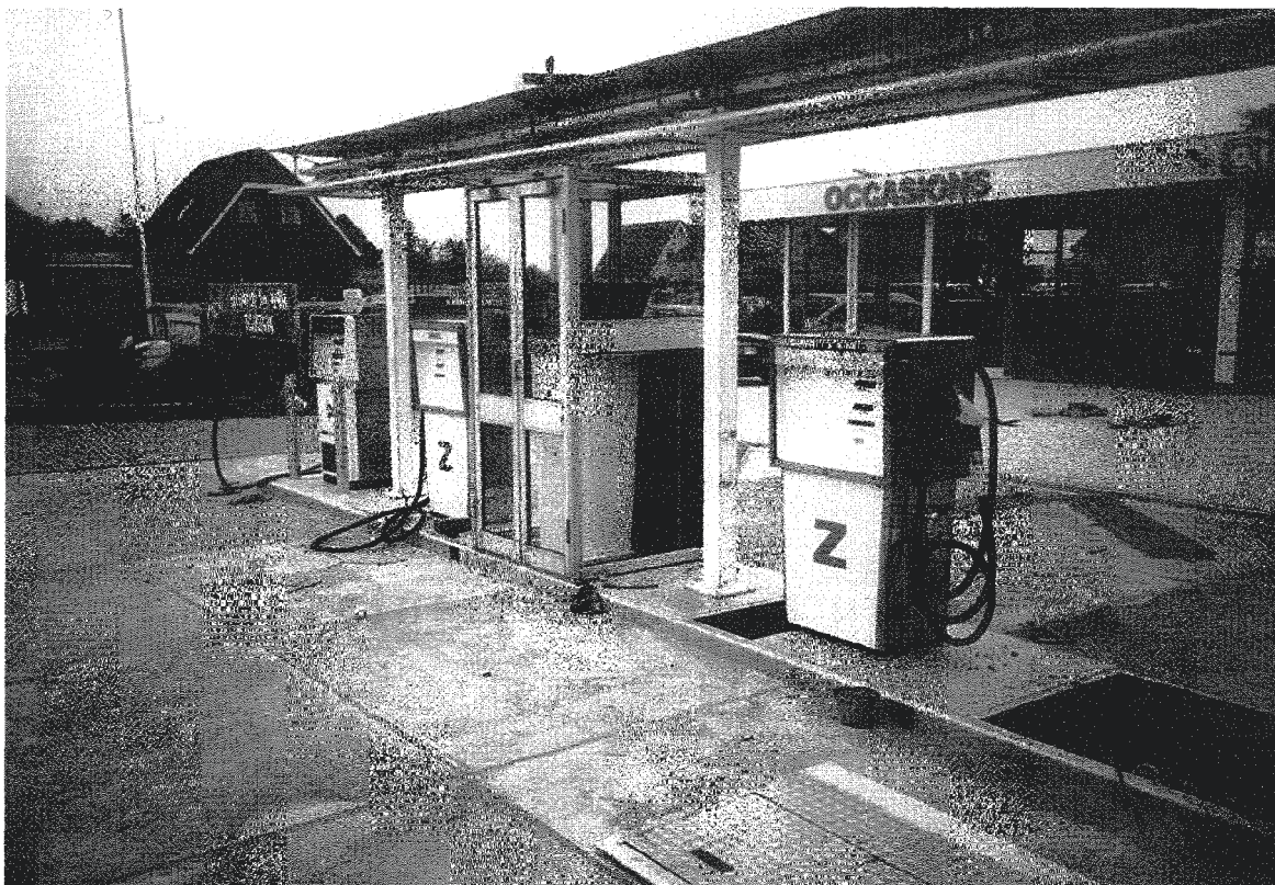
Bodembescherming bij een tankstation door prefab elementen.
