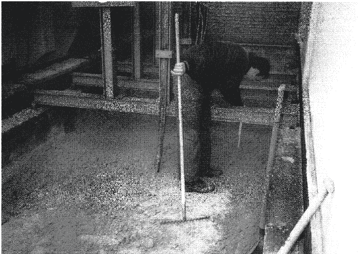
Werkzaamheden bij het aanbrengen van een minerale onderafdichting.
