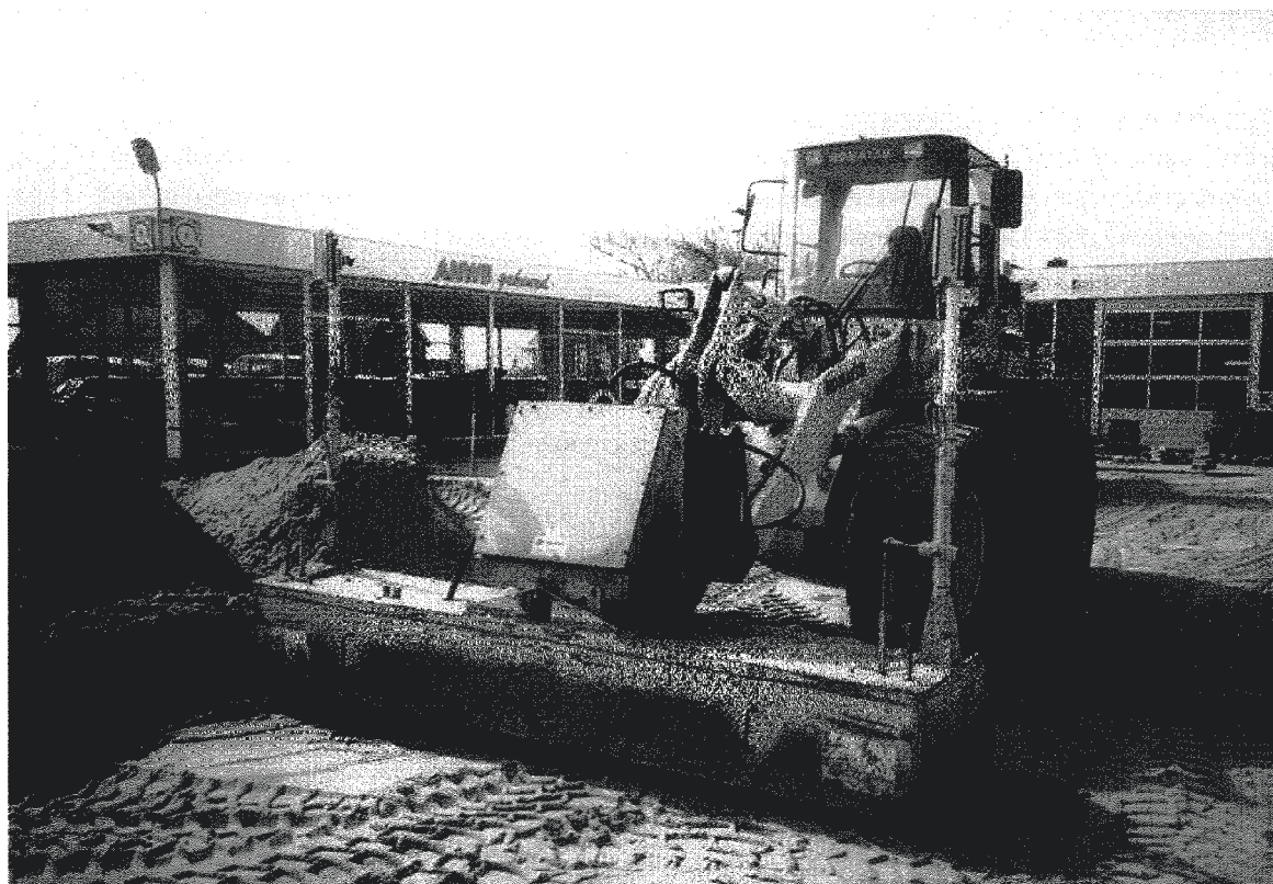
Het aanbrengen van een zandbed.
